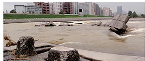
写真－ 2.2.4.7 床止の護床ブロックの被災状況（平成 23 年出水後の豊平川）
