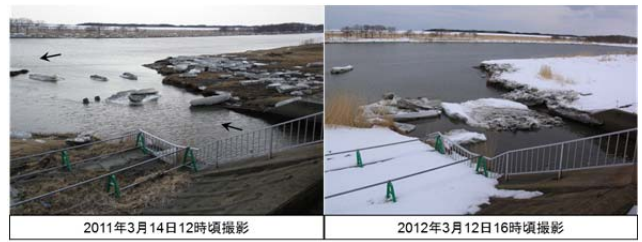
写真-4 浦幌十勝川 KP.1.1 地点 U 1 水門
