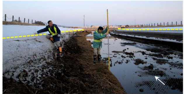
写真-7 新釧路川 K 1 樋門 (KP. 2.80 R) における浸水痕跡
