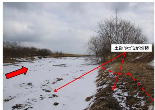
写真-11 和天別川津波痕跡 (地点②) (結氷上に土砂やゴミが見られる)
