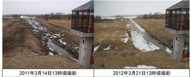
写真一九 鷓川 KP.0.9 地点 M 1 樋門吐口
