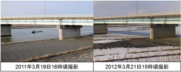
写真-10 厚真川 KP.1.7 地点臨港大橋
