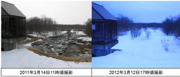
写真一六 浦幌十勝川 KP.4.2 地点 U 3 樋門吐口
