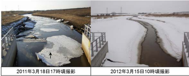
写真一七 新釧路川 KP.4.5 地点 S 1 樋門吐口
