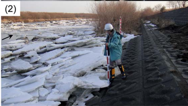
写真-12 水位観測所付近の痕跡状況 (KP. 2. 55 R 付近)
