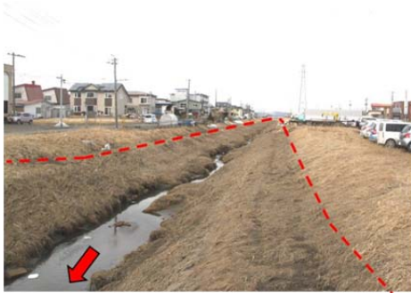
写真-1 星ガ浦川津波痕跡
