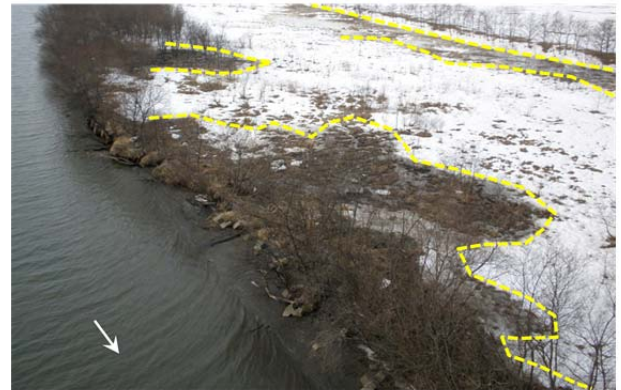
写真-3 十勝川 T 2 橋梁より撮影した高水敷の冠水状況 (KP. 5. 72L)
