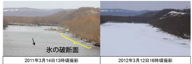
写真-5 浦幌十勝川 KP.3.0 浦幌大橋より上流
