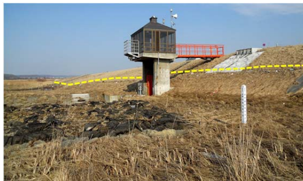
写真-13 沙流川 S 1 樋門における痕跡 (KP. 0. 40 L)
