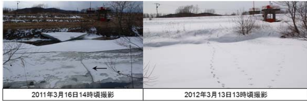
写真-12 和天別川 KP.1.3 地点 W 1 樋門
