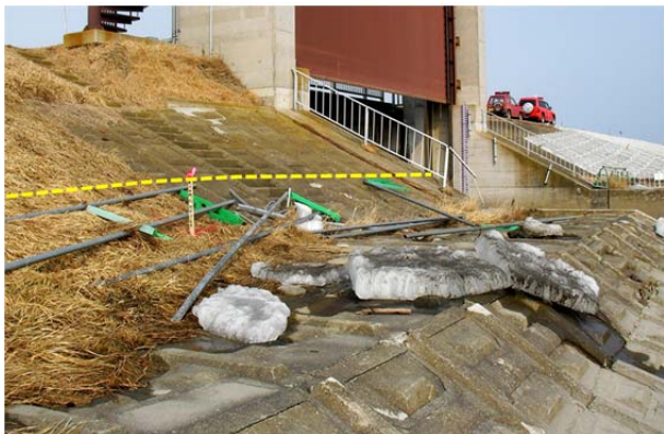
写真-4 浦幌十勝川 U 1 水門における津波痕跡 (KP. 1. 10 L)
