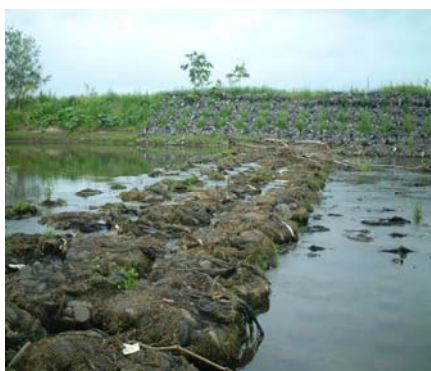
②本川に透過型分流堰を設置。
