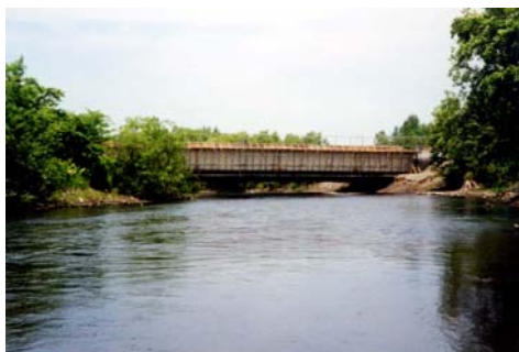
③試験用仮橋を設置。 (既設の国道橋を再利用)
