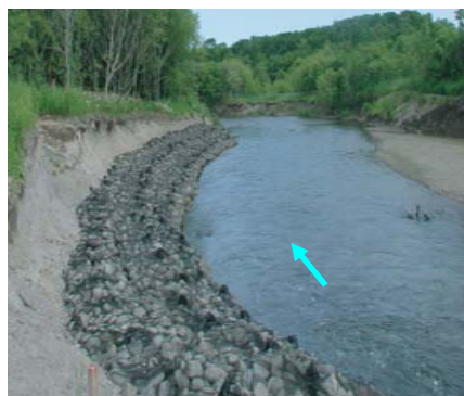
分流部(水衝部)の河岸侵食の進行を防止するため護岸を設置
