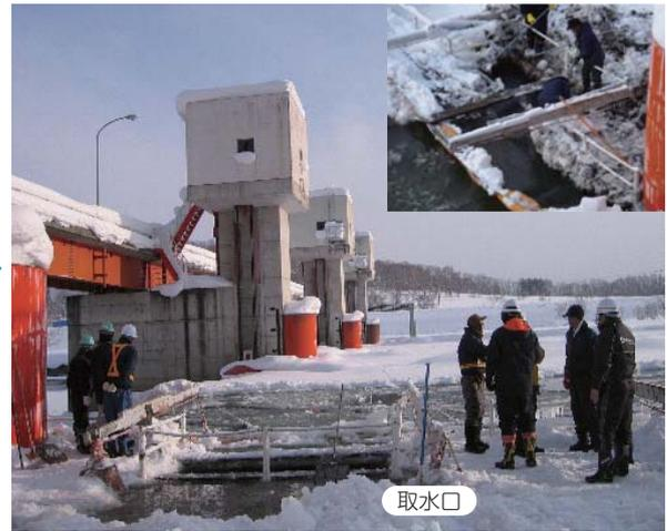
取水口に、晶氷が流入したため、取水障害が発生
