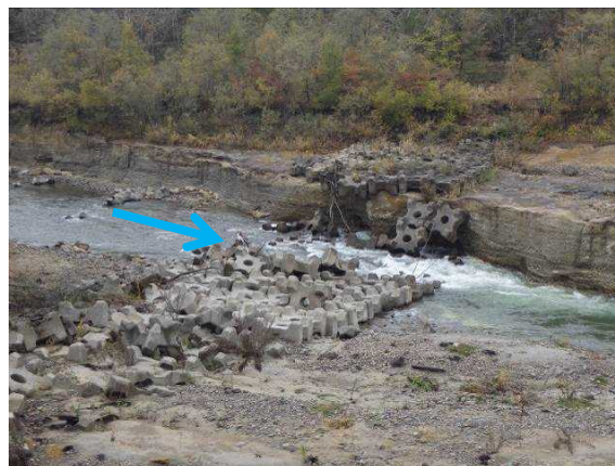
図 1.8 帯工の被災
