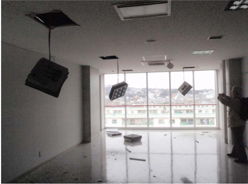
被災直後の写真、天井から通気口？が落下
