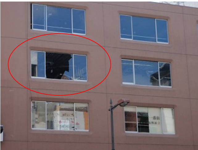
ビルのガラスが割れている(左). 壁が剥がれているが倒壊などには至っていない(右).
