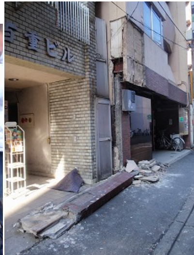
被災時も営業して助かりました(左), 古い建物の柱の崩落(右).
