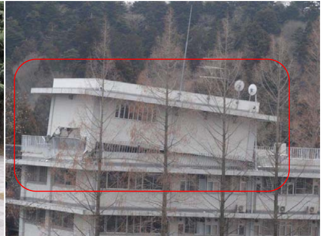
建物から離れて人々は立ちすくむ(左), 川内合同研究棟5階の屋上施設が崩壊していた(右). その他の周りの建物は無事. 右の写真は千葉大学の吉田睦教授の提供です.
