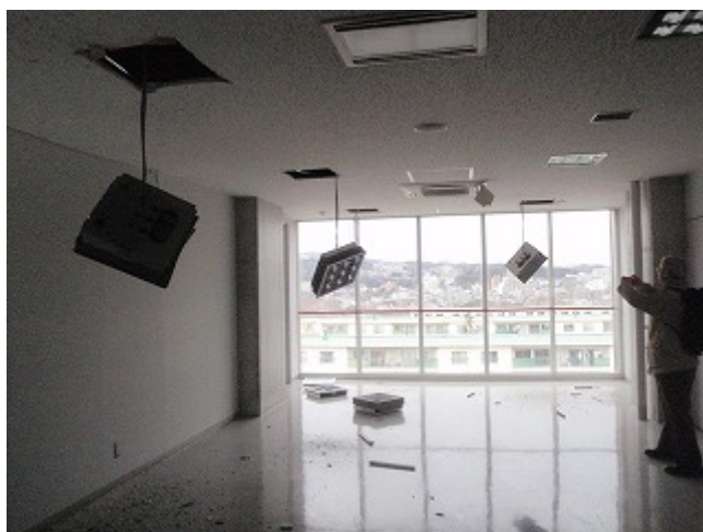
通気口がぶら下がっている(左). 会議室を挟む壁が崩壊(右)
