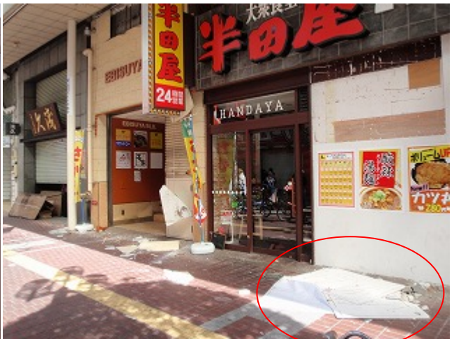
ビルのガラスが割れている(左). 壁が剥がれているが倒壊などには至っていない(右).
