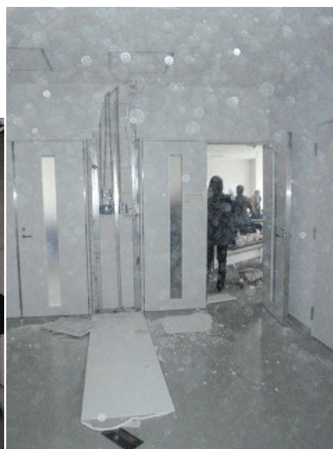
通気口がぶら下がっている(左). 会議室を挟む壁が崩壊(右)
