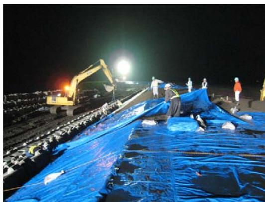
写真3-13 照明車を設置しての夜間作業状況
