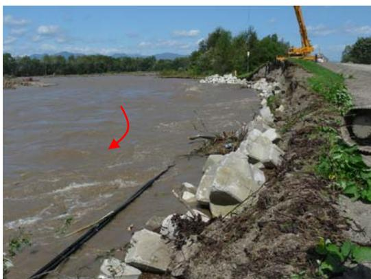
写真3-12 根固めブロック投入状況
