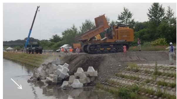
ケース6 不整地運搬車ダンプアップ
