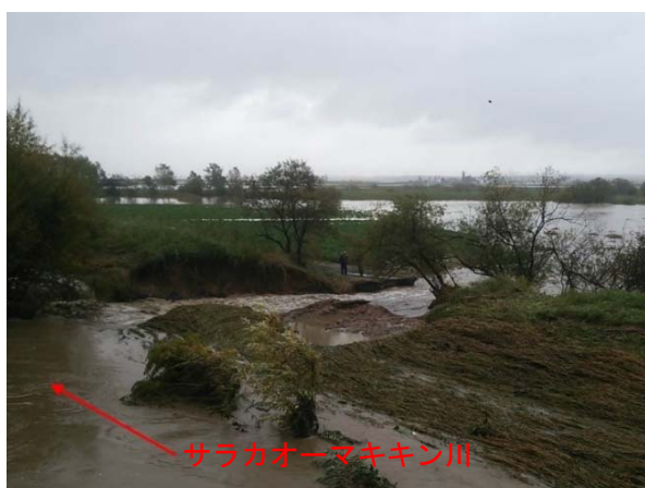
写真 1.11 サラカオーマキキン川の堤防決壊状況
