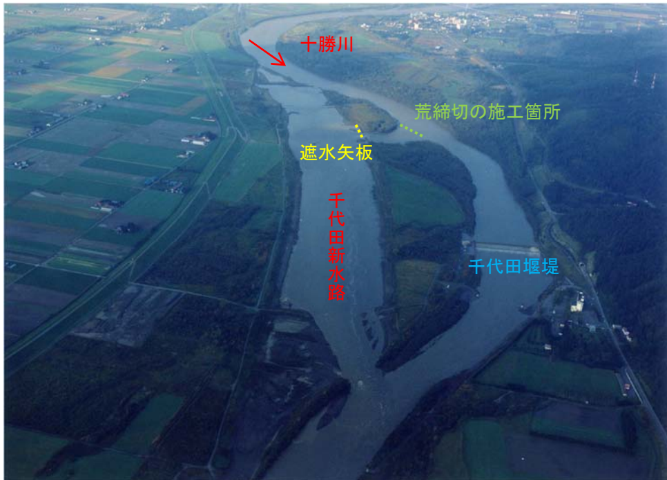
写真 1.19 工事中の千代田新水路への洪水流入状況（10月3日 7:45 撮影）
