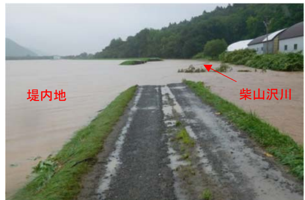
写真 1.8 柴山沢川の堤防決壊状況
