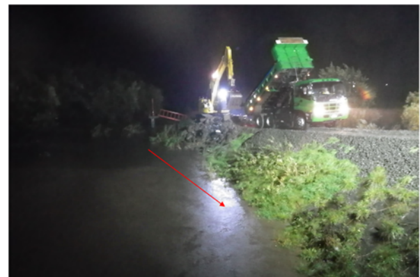
写真 1.18 天端拡幅後の状況
