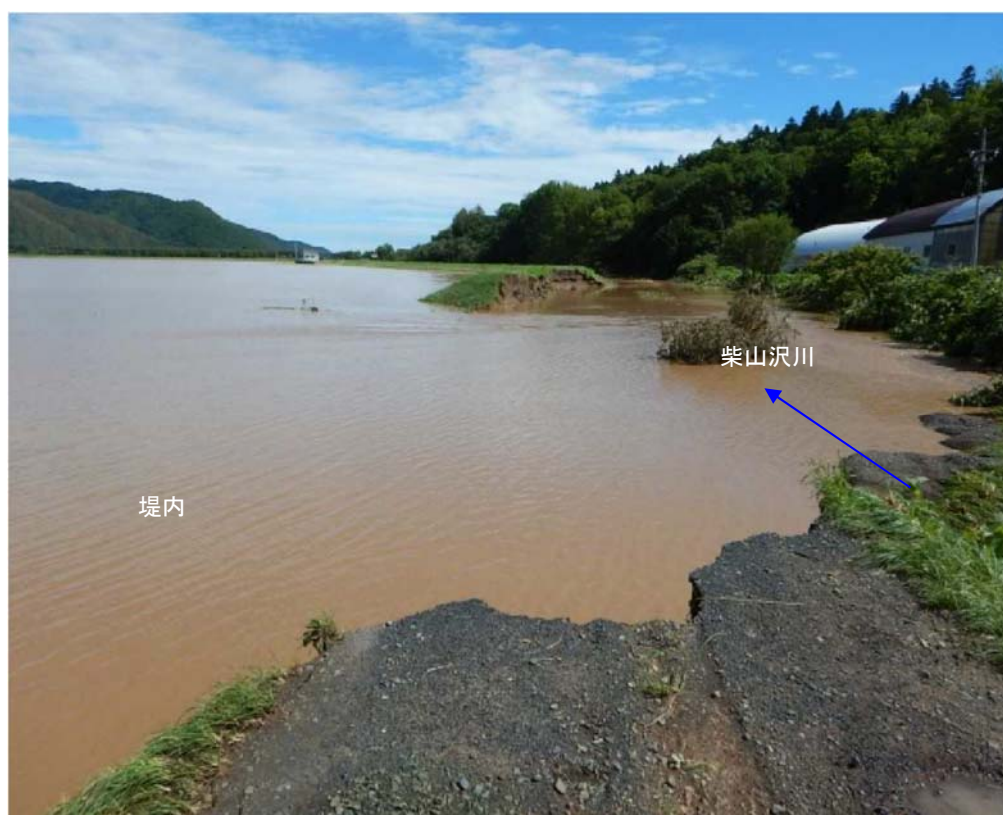
写真 2.3 常呂川水系柴山沢川の堤防決壊状況
