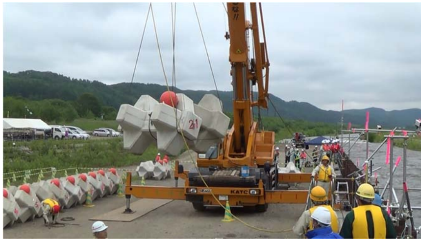
写真 4.5 ブロック 2 個連結状況
