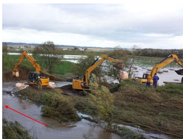
写真 1.12 大型土のうのバケツリレー
