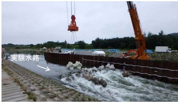
ケース1 クレーン+ブロック投入装置
