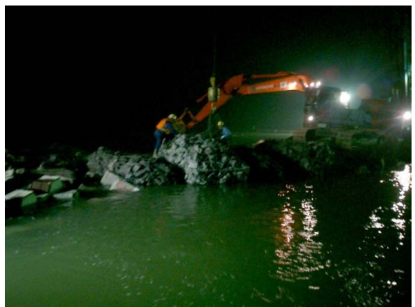
写真 1.25 ふとんかごの追加投入による 隙間の閉塞
