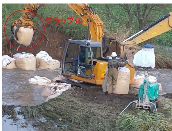
写真 1.13 大型土のうの投入状況
