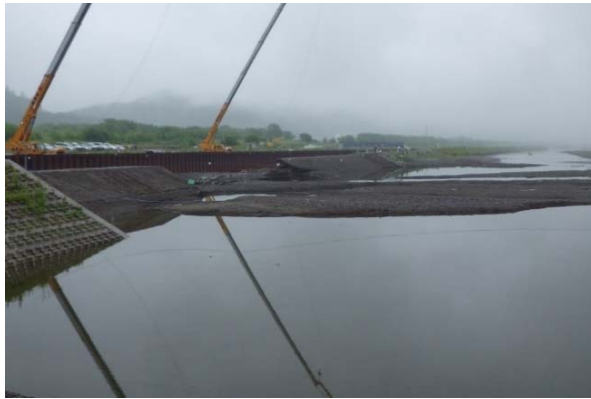
ブロックを撤去し通水開始
