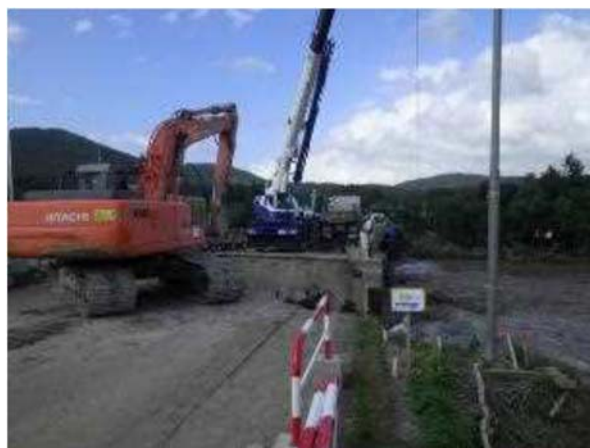
写真 1.5 バックホウによるブロックの押し落とし
