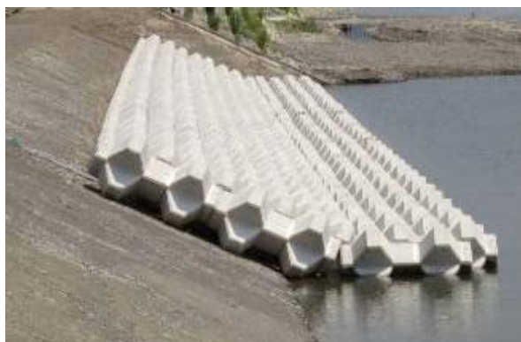
写真 3.1 破堤拡幅抑制工の設置例
