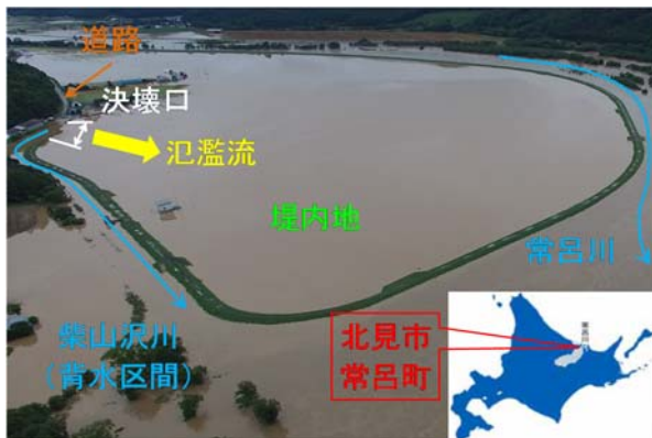
写真 1.7 柴山沢川の氾濫状況
