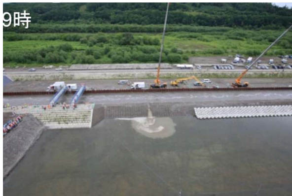
9時 越水開始 ブロックの上流側の切欠き部から越流が始まる
