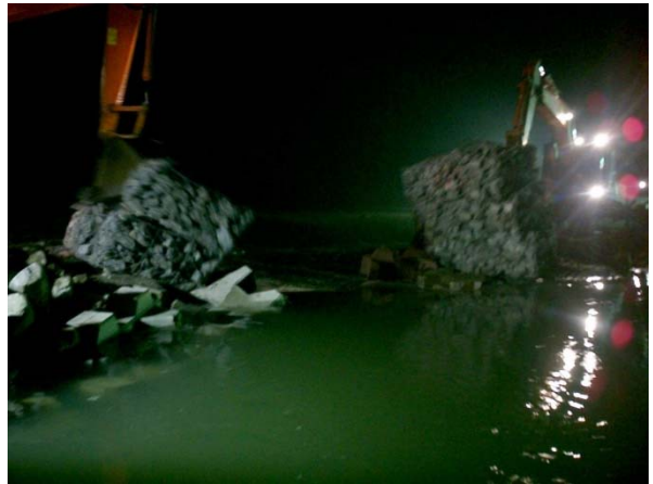
写真 1.23 大型ふとんかごの押し出し 作業開始
