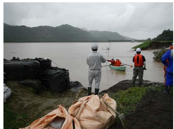
写真 1.10 ボートによる深掘れ部の調 査
