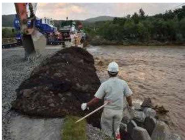
写真 1.6 太平橋橋台背後の応急復旧
