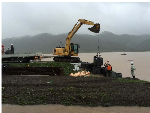
写真 1.9 バックホウによる大型土のう 設置
