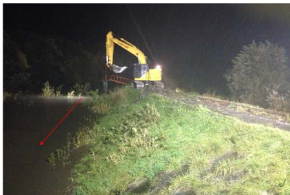
写真 1.17 締切工事着手直後の状況
