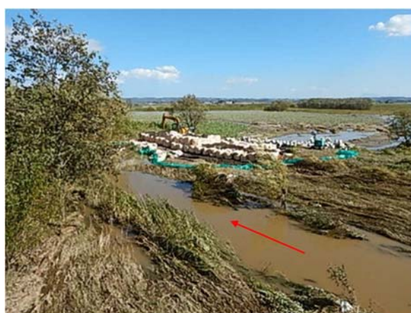
写真 1.14 大型土のうによる締切が概ね完了した状況
