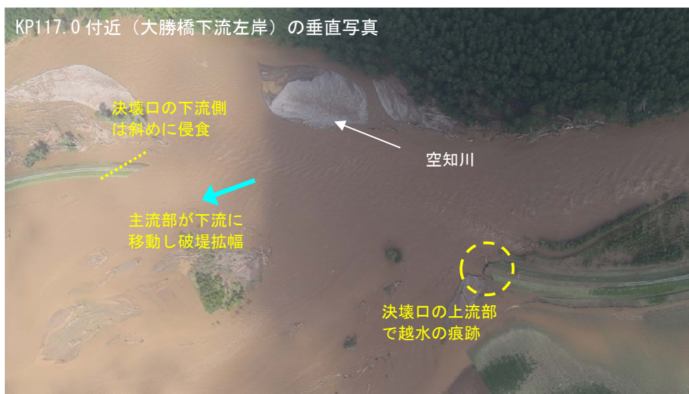
写真 2.1 石狩川水系空知川の堤防決壊状況
