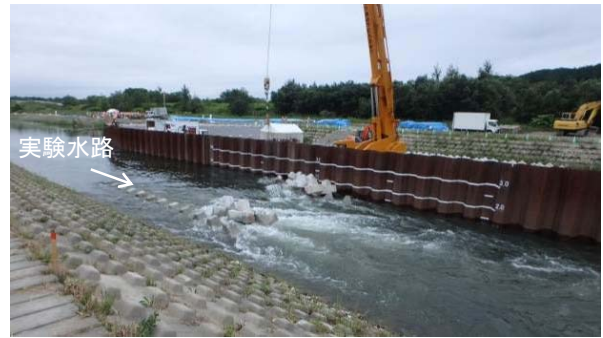
ケース2 クレーン+オートフック
