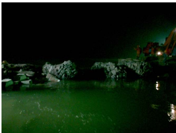
写真 1.24 大型ふとんかごの押し出し 作業終了
