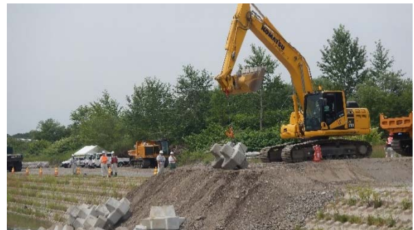
ケース4 バックホウ+オートフック+押出
