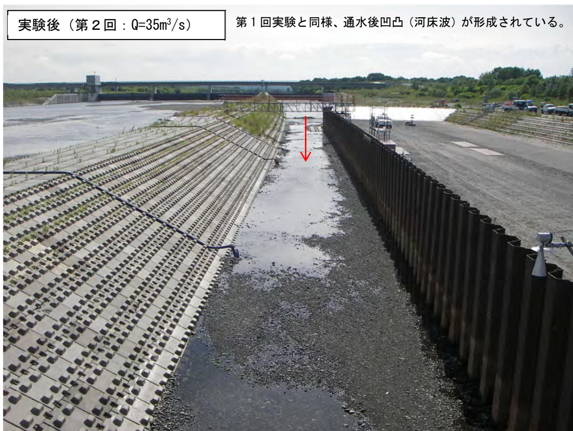
図 1-8 下流人道橋（P520）より上流側方向
