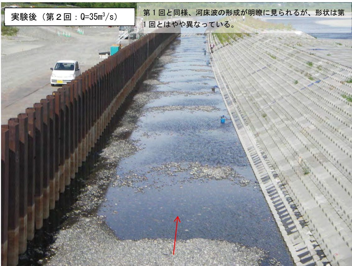
図 1-9 下流人道橋（P520）より下流側方向
