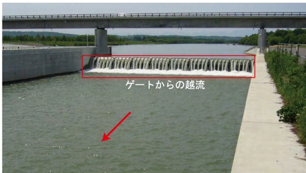
図 1-3 ゲートからの通水状況
