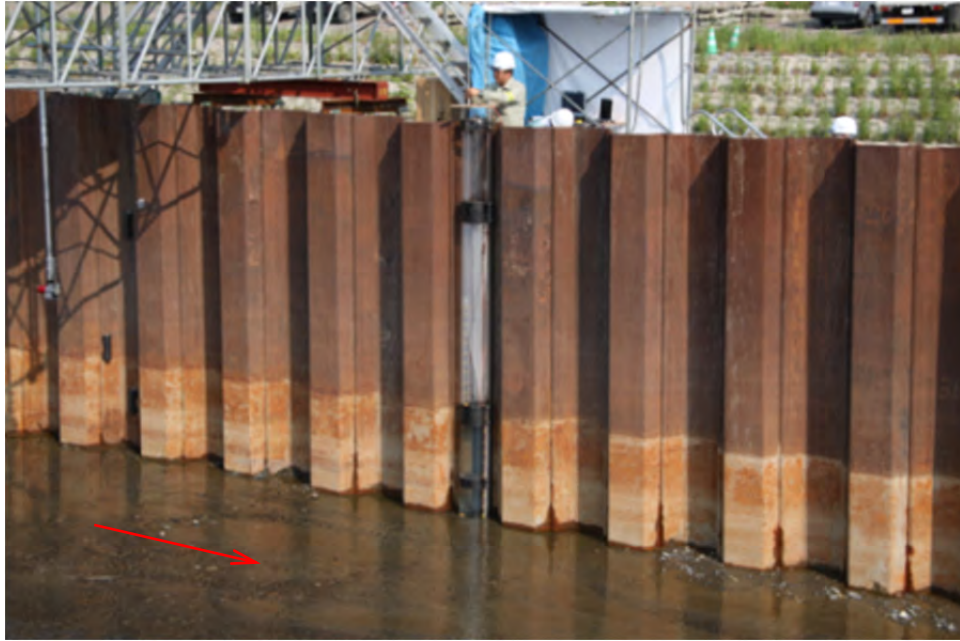
図 2-18 水路側壁の矢板（左岸側）
