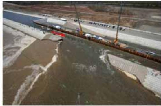
破堤進行過程 (t=45min)
