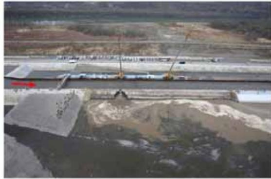
破堤進行過程 (t=50min)
