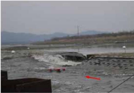
破堤進行過程 (t=65min)
