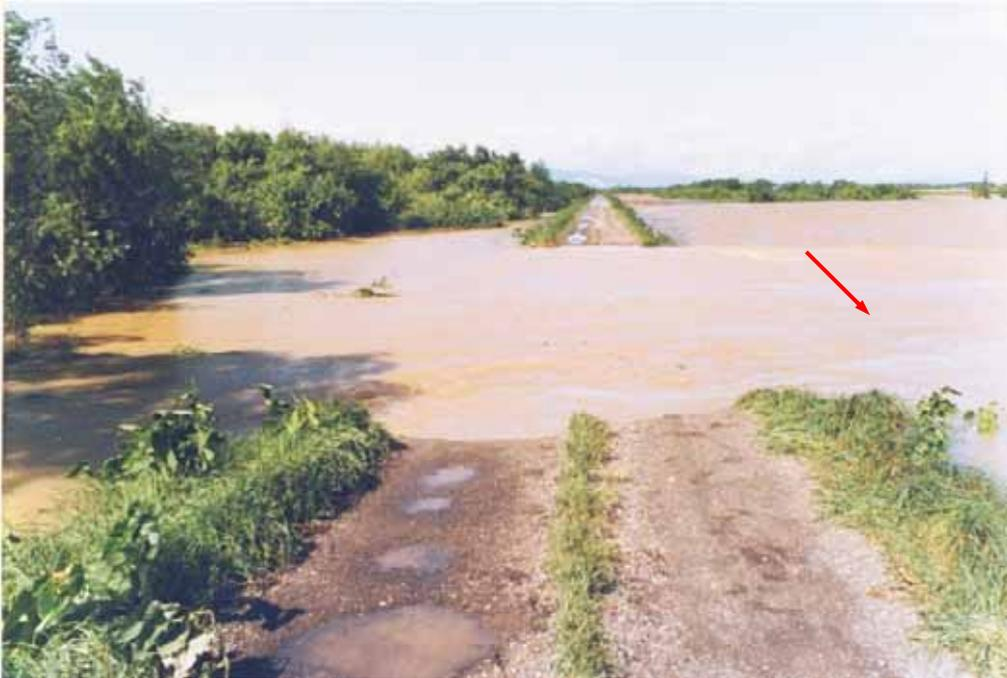
写真- 1 破堤状況 (①真熱別川)
