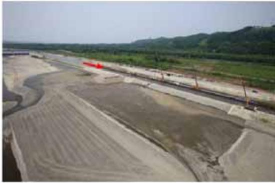
破堤進行過程 (t=28min)
