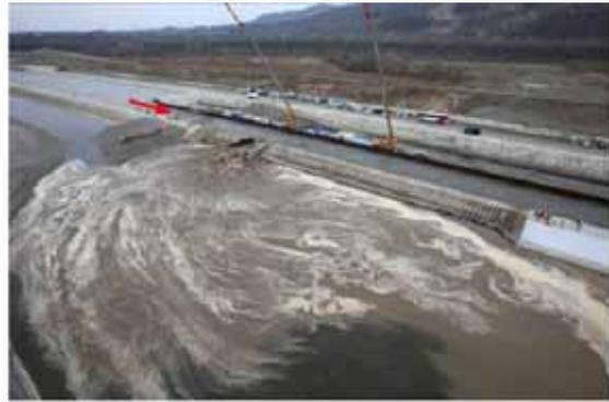
破堤進行過程 (t=60min)
