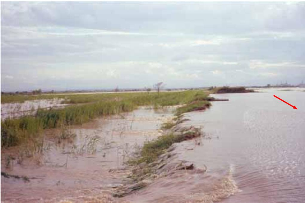
写真- 2 破堤状況 (②石狩川：美原 36 線地先)
