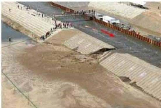
破堤進行過程 (t=15min)
