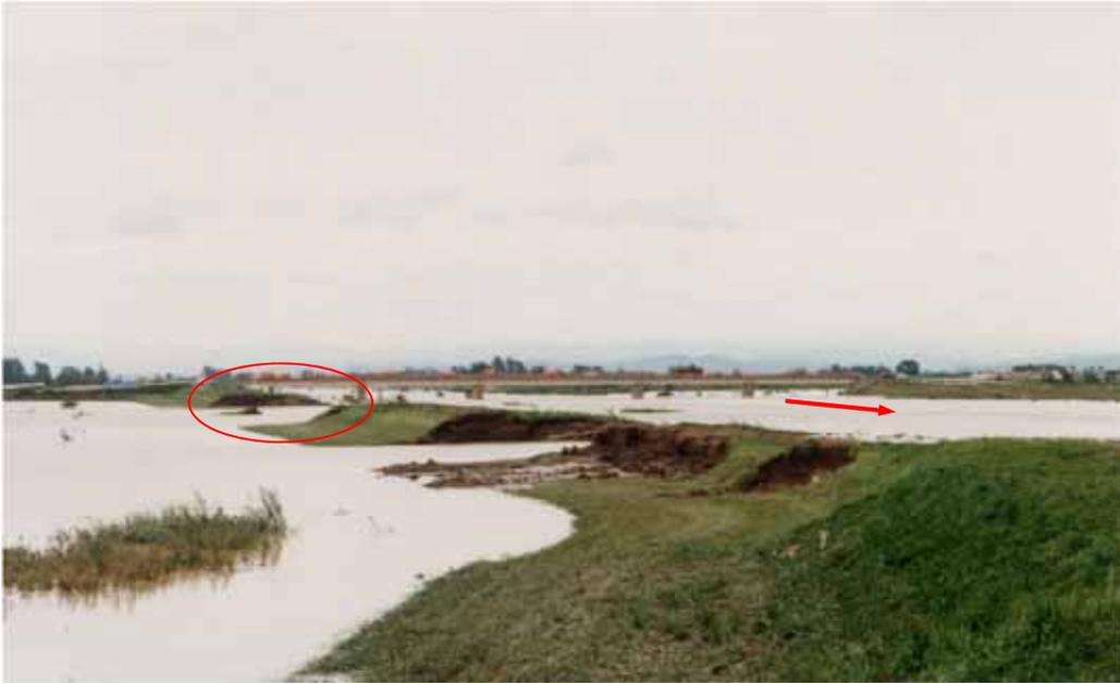
写真- 5 破堤状況 (⑤幌向川 : 7 西 1 号橋下流)
