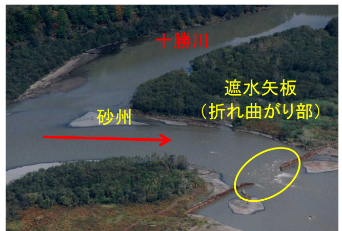
写真-32 遮水矢板の一部折れ曲がりと締切部下流側の砂州 (10月8日11:30撮影 北海道開発局提供 一部加筆)
