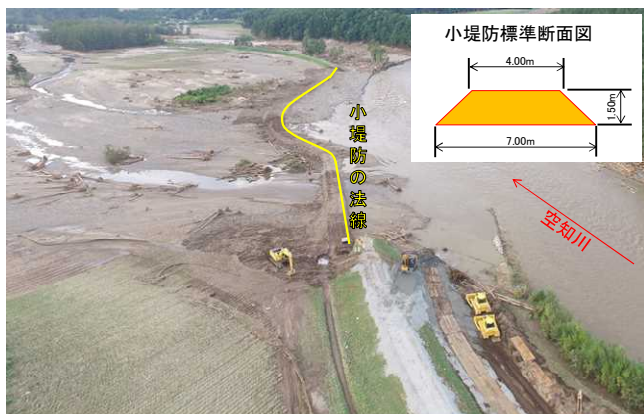
写真-3 小堤防の法線と標準断面図 （9月2日撮影 北海道開発局提供 一部加筆）
