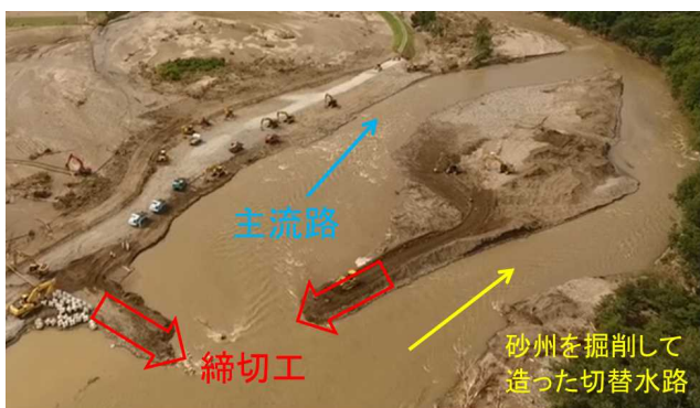
写真-50 流木使用前の主流路を切り替えるための締切工事（土木学会北海道豪雨災害調査団提供 一部加筆）
