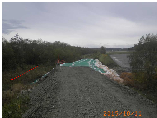
写真-23 止水作業完了状況（北海道提供 一部加筆）
