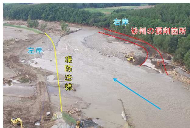
写真-47 左岸堤防法線と切替水路の掘削状況（赤点線） （北海道開発局提供 一部加筆）
