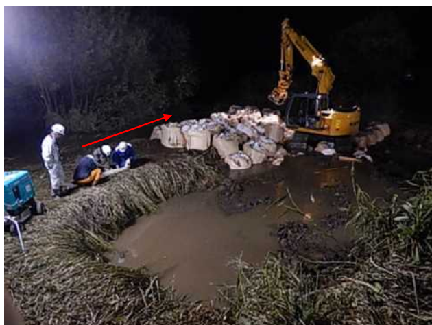
写真-29 大型土のうによる締切が概ね完了した状況
