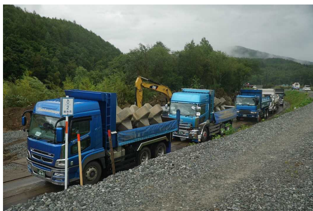
写真-57 ダンプトラックによる根固ブロックの運搬状況 (土木学会北海道豪雨災害調査団提供)
