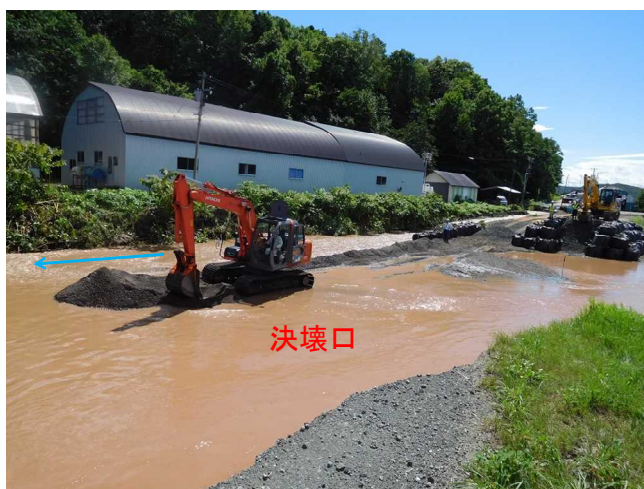
写真-9 仮道の建設（8月23日の着手時点）
