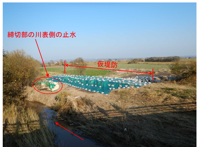
写真-26 止水作業完了状況 （作業完了から約1週間後に撮影）
