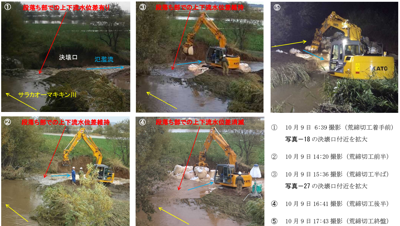
写真-30 締切作業の進捗に伴う決壊口付近の水位変化
