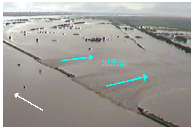
写真-60 一連区間で2箇所の堤防決壊が発生した石狩川本川 (北海道開発局提供 一部加筆)
