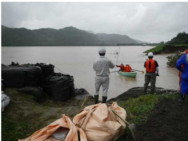
写真-8 ボートによる深掘れ部の調査 (北海道開発局提供 一部修正)
