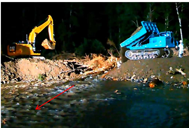
写真-55 キャリアダンプによる土砂の投入状況 (北海道開発局提供 一部加筆)
