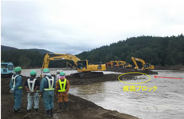
写真-49 根固ブロック使用後の主流路を切り替えるための締切工事（北海道開発局提供 一部加筆）
