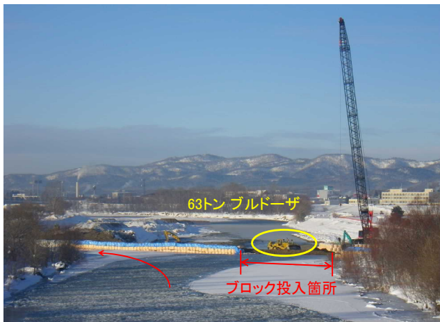
写真-46 締切完了後の状況及び63トンのブルドーザ (北海道開発局提供 一部加筆)
