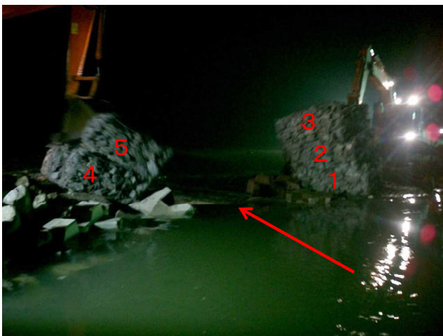
写真-39 石籠の押し出し作業開始 (北海道開発局提供 一部加筆)
