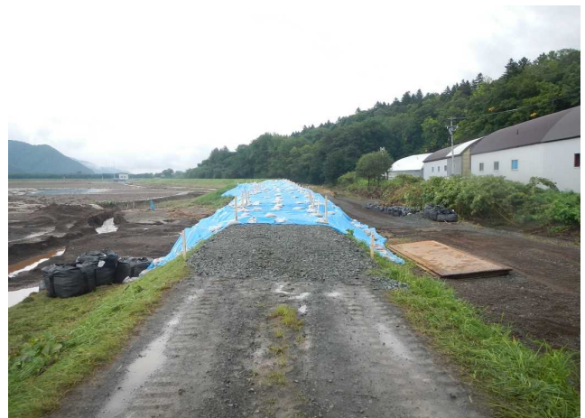
写真一 柴山沢川の緊急締切完了 (北海道開発局提供)
