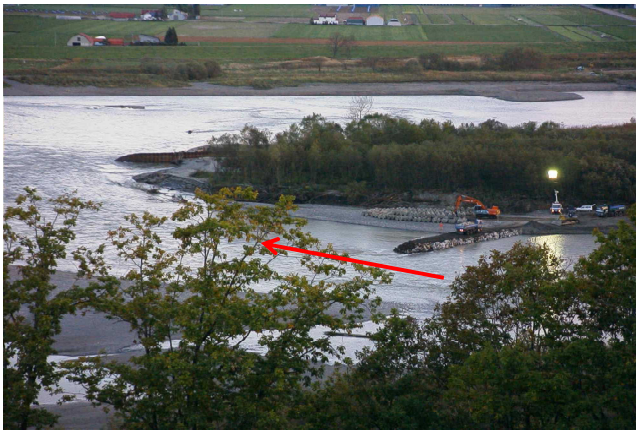
写真-35 クレーンヤード造成前の締切工事の進捗状況 （北海道開発局提供 一部加筆）
