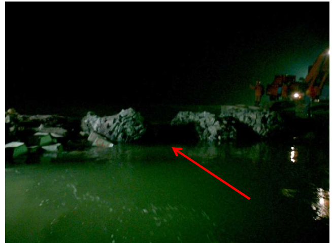
写真-40 石籠の押し出し作業終了 (北海道開発局提供 一部加筆)
