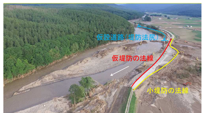
写真-2 仮堤防築造、仮設道路及び小堤防築造の位置関係 （9月3日撮影 北海道開発局提供 一部加筆）
