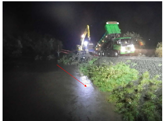
写真-22 天端拡幅後の状況（北海道提供 一部加筆）
