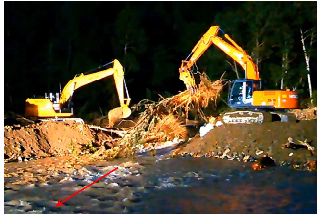
写真-53 流木の投入状況（北海道開発局提供 一部加筆）
