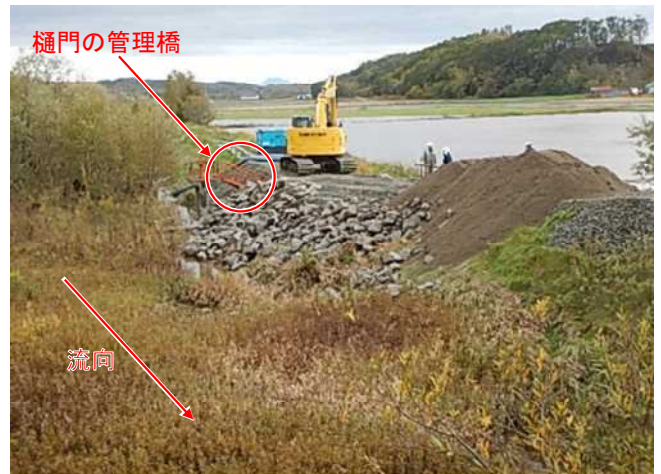
写真-16 女満別川の割石等による締切が完了した状況 (10月9日の午後撮影)
