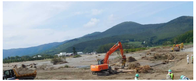
写真-52 流木の収集状況
