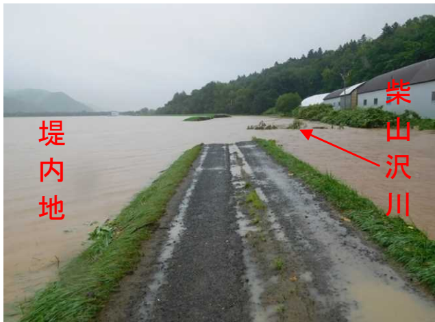
写真一 柴山沢川の堤防決壊 (8月21日11:20撮影)
