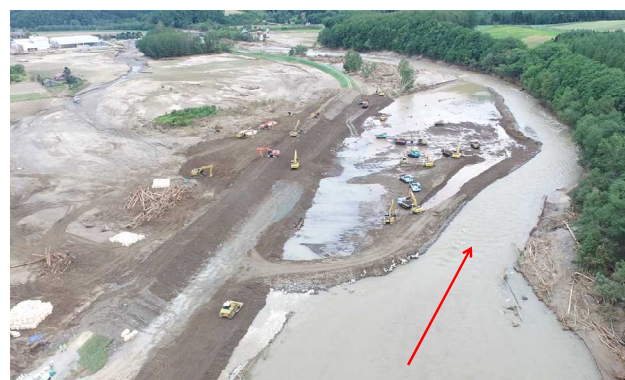
写真-48 河道内の土砂の仮堤防への流用状況 （北海道開発局提供 一部加筆）
