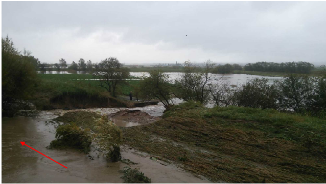
写真-18 サラカオーマキキン川の堤防決壊状況 (北海道提供 一部加筆)
