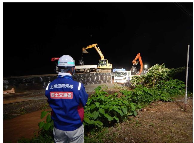
写真-11 堤防天端と仮道の両方からの大型土のうの設置 (23日の夜撮影 北海道開発局提供)
