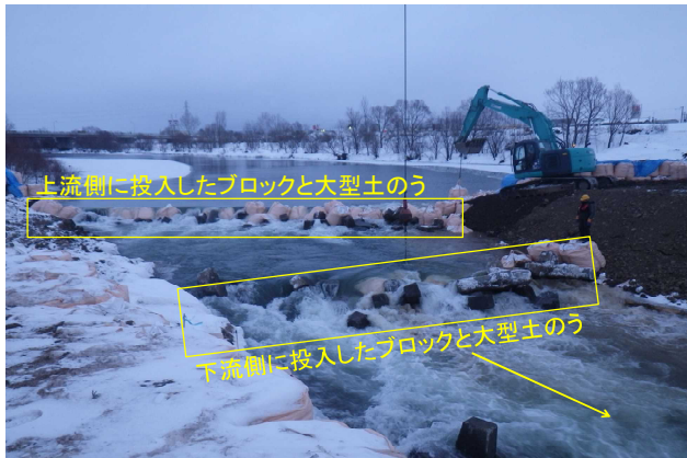
写真-44 ブロックと大型土のうの投入状況 (北海道開発局提供 一部加筆)
