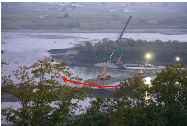
写真-36 クレーンヤード造成後の締切工事の進捗状況 （北海道開発局提供 一部加筆）
