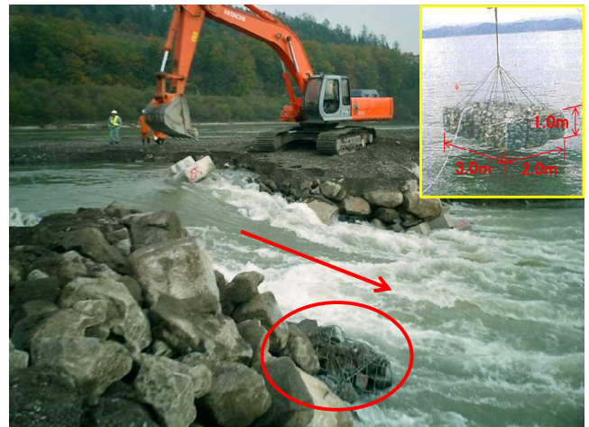
写真-37 狭まった締切部の激しい流れと締切部の底部に設置された10トンの石籠（一部が見える）
