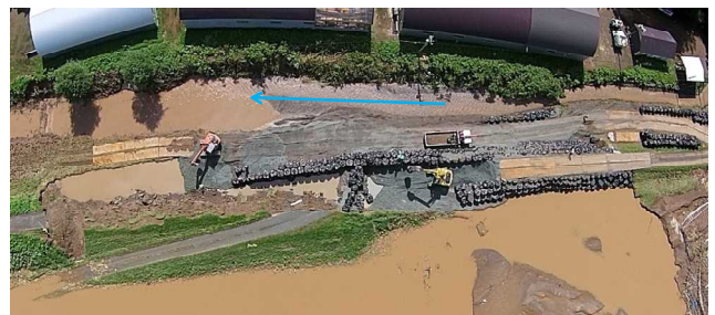
写真-10 仮道の建設（8月24日の概成時点） (土木学会北海道豪雨災害調査団提供 一部加筆)
