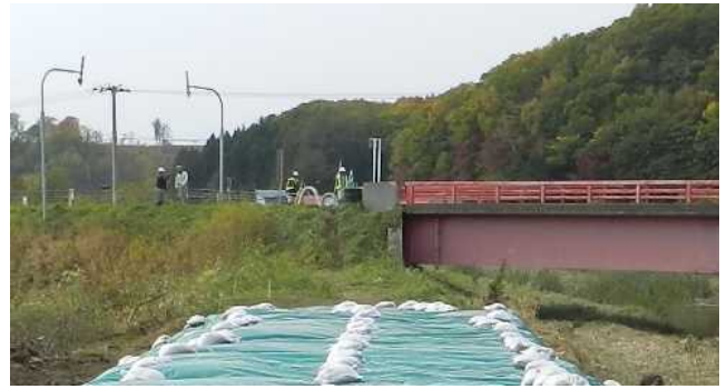
写真-24 橋の袂付近の状況（北海道提供）
