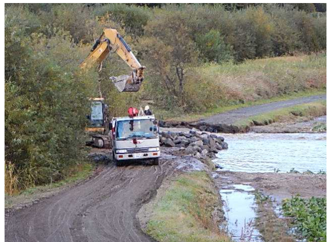
写真-25 耕作道路を使用した大型土のうの運搬状況
