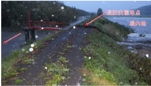
写真-14 女満別川の堤防決壊直後の堤防の状況 (10月8日 16:39 撮影 北海道開発局提供 一部加筆)
