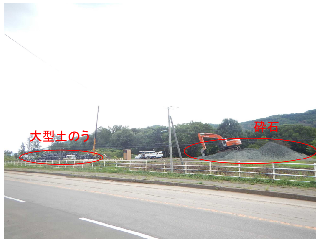
写真-7 資材の仮置きヤード兼大型土のう製作ヤード
