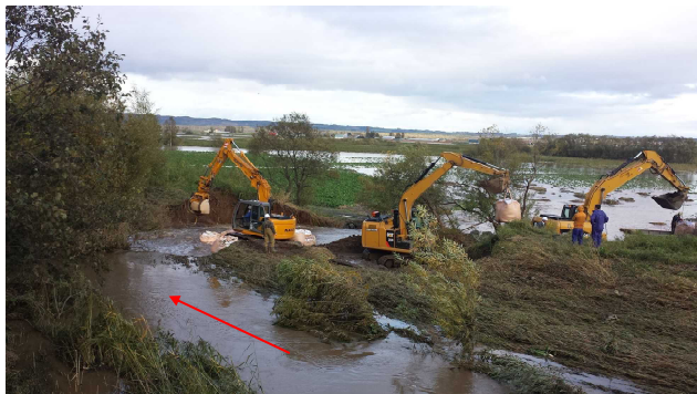
写真-27 大型土のうの投入状況
