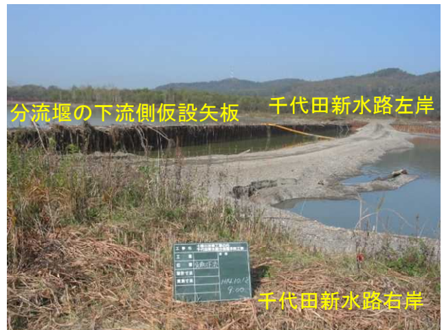
写真-33 被災後に新たに整備した仮設道路 (北海道開発局提供 一部加筆)
