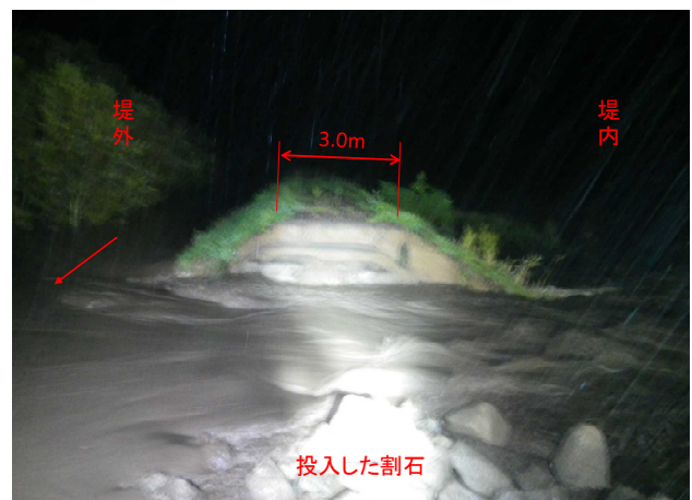
写真-20 女満別川の堤防決壊状況 (10月8日22:42撮影 北海道提供 一部加筆)
