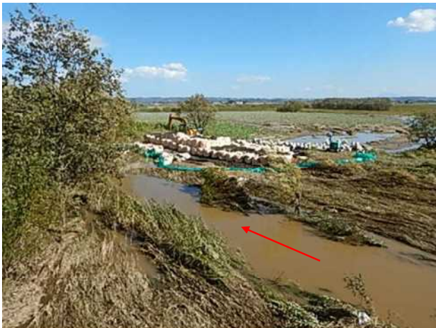
写真-19 サラカオーマキキン川的大型土のう等による 締切が概ね完了した状況
