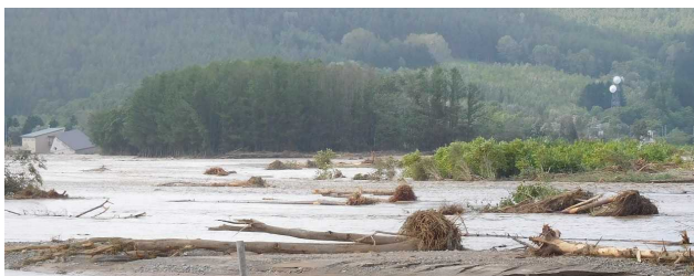
写真-51 堤防決壊箇所周辺の流木
