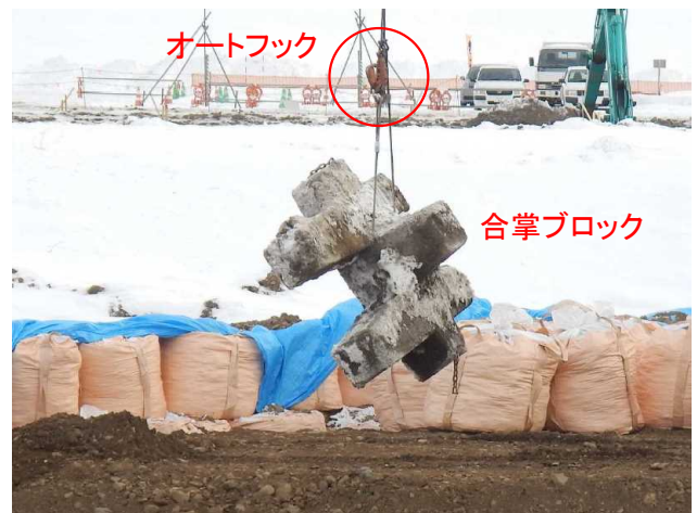
写真-43 オートフックで吊り上げた合掌ブロック （北海道開発局提供 一部加筆）
